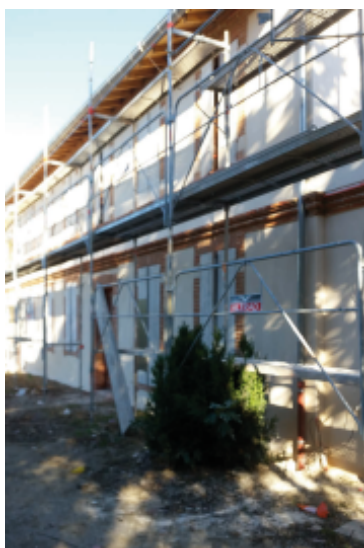
La façade rénovée
